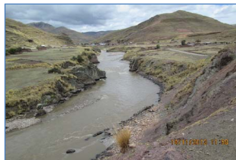
Bocatoma Santa Bárbara
